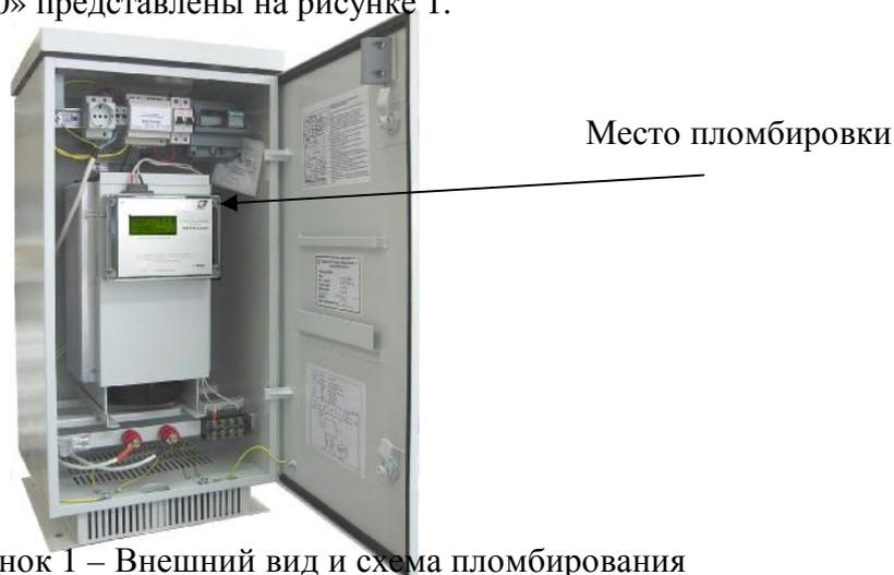
Рисунок 1 – Внешний вид и схема пломбирования
